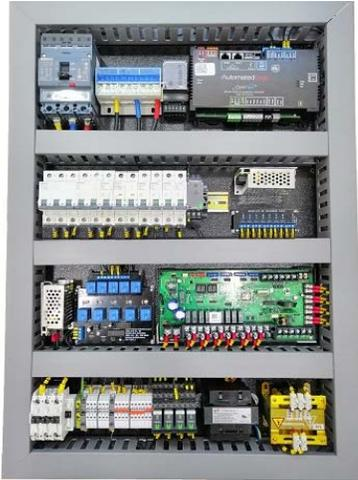
**•Interruptor General:** La unidad posee un interruptor principal (general) de desconexión, localizado en el tablero opcional del equipo. Los interruptores son de tipo termo magnéticos con clasificación de capacidad interrumpida según UL489/CSA C22.2/IEC- 947. KAIC: 50.
